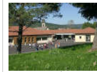
Construit, rénove et entretient les bâtiments
