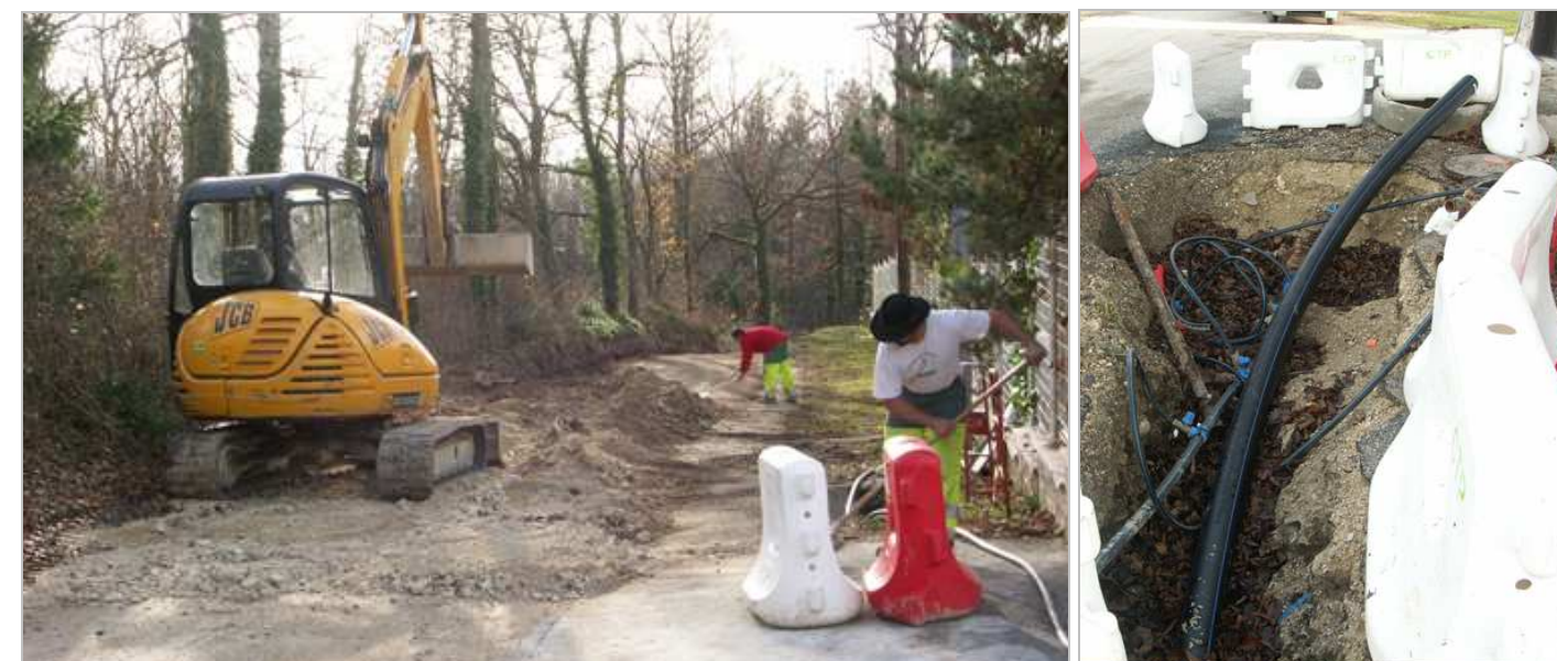
Renforcement de l'alimentation en eau, chemin de Roveya
